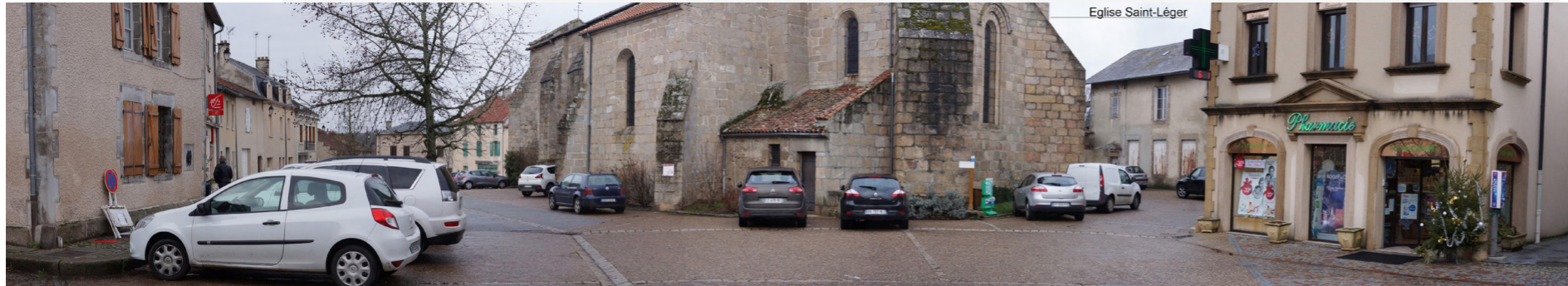
Point de vue initial : place de Bessines-sur-Gartempe - abords de l'église inscrite - Éolienne la plus proche : 10.159 km. Intérêts : monument historique - urbanisme proche. Angle de vue : 148.8°
